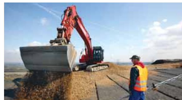
Aufwendige Vorbereitungsarbeiten sind auf der Halde Oberscholven im Gang
